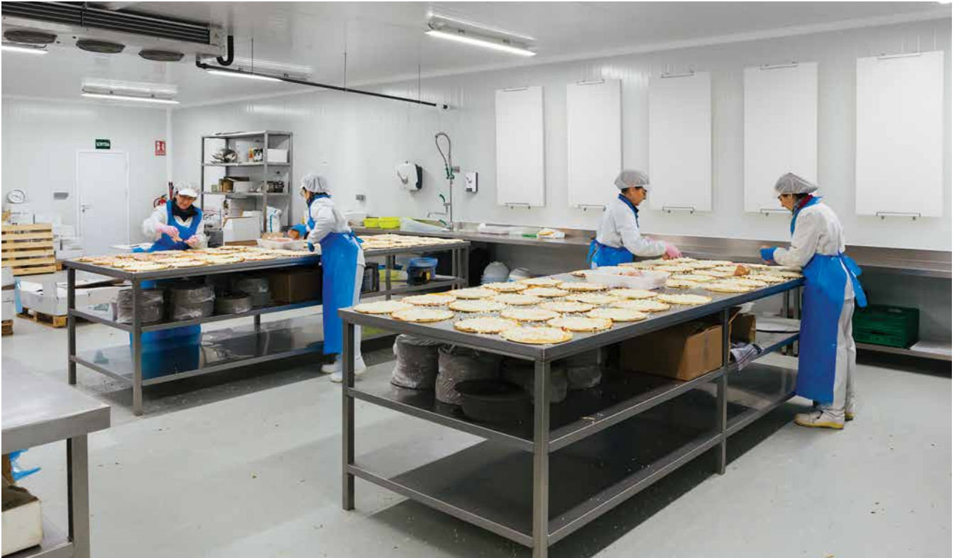
Figur 7. Vægabsorbent monteret med beslag
