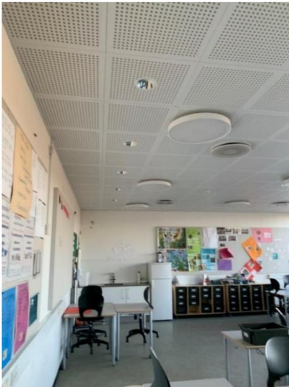
Figur 8 Klasselokale på Herstedlund Skole med downlights, som efter behov kan tændes for at belyse opslagstavlen og/eller for at udjævne luminansforskelle i rummet
